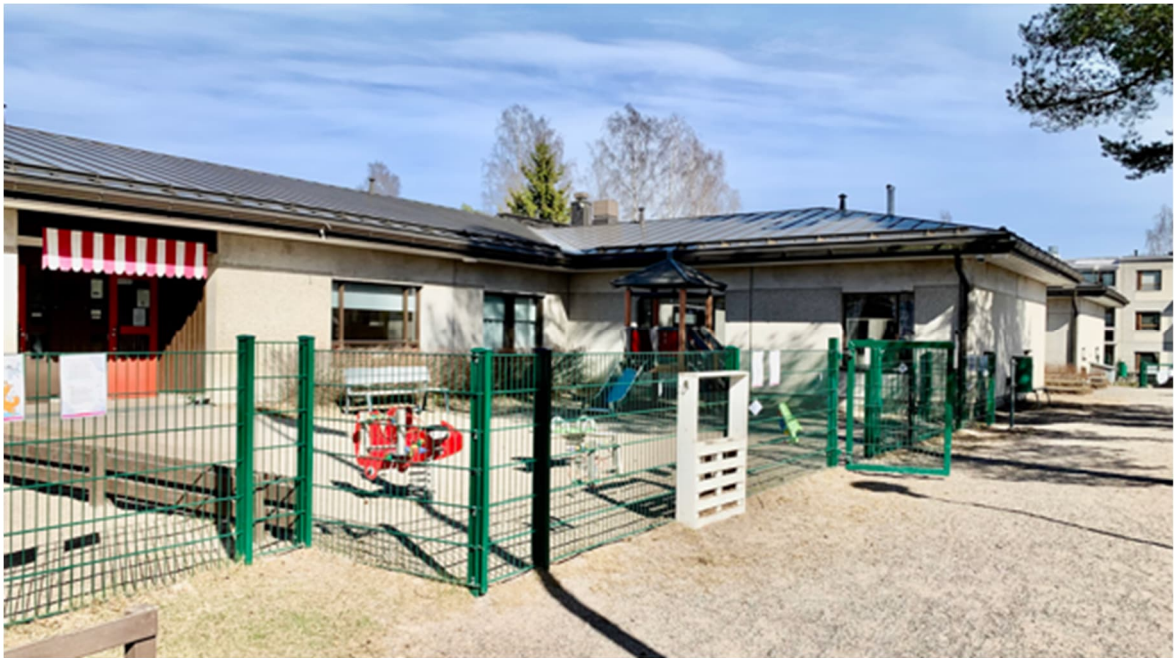
Vantaanlaakson päiväkoti. Julkisivut ovat betonia.
