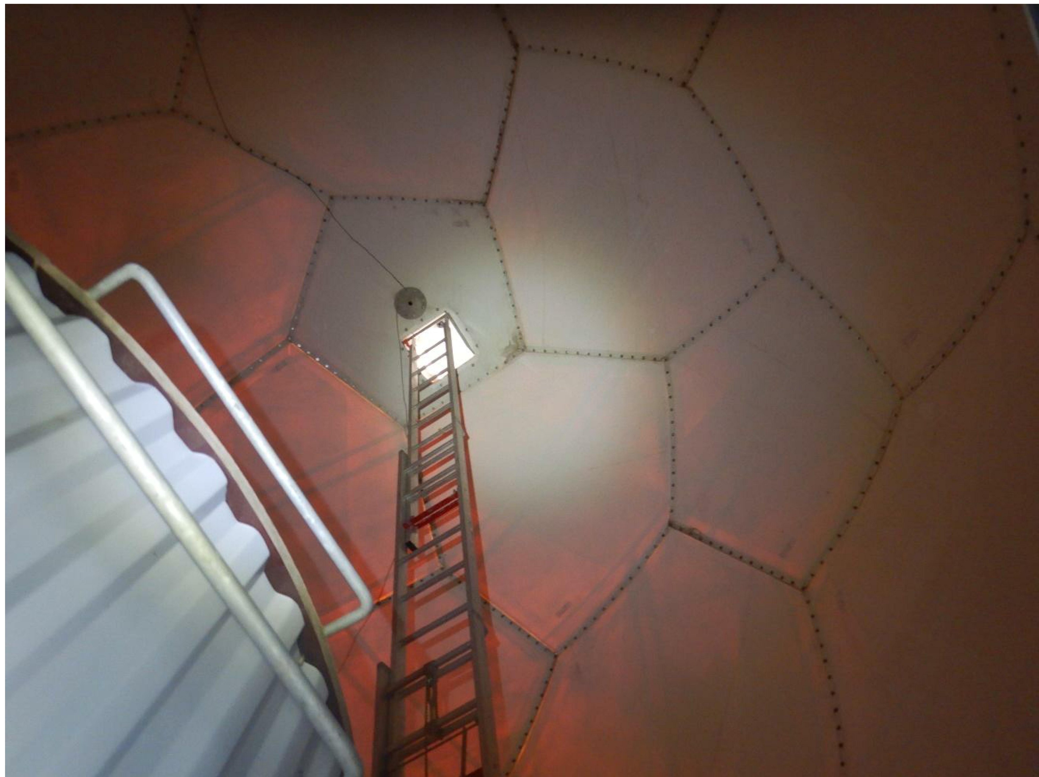
Kuva 12. Sääaseman kupolirakenne sisäpuolelta
