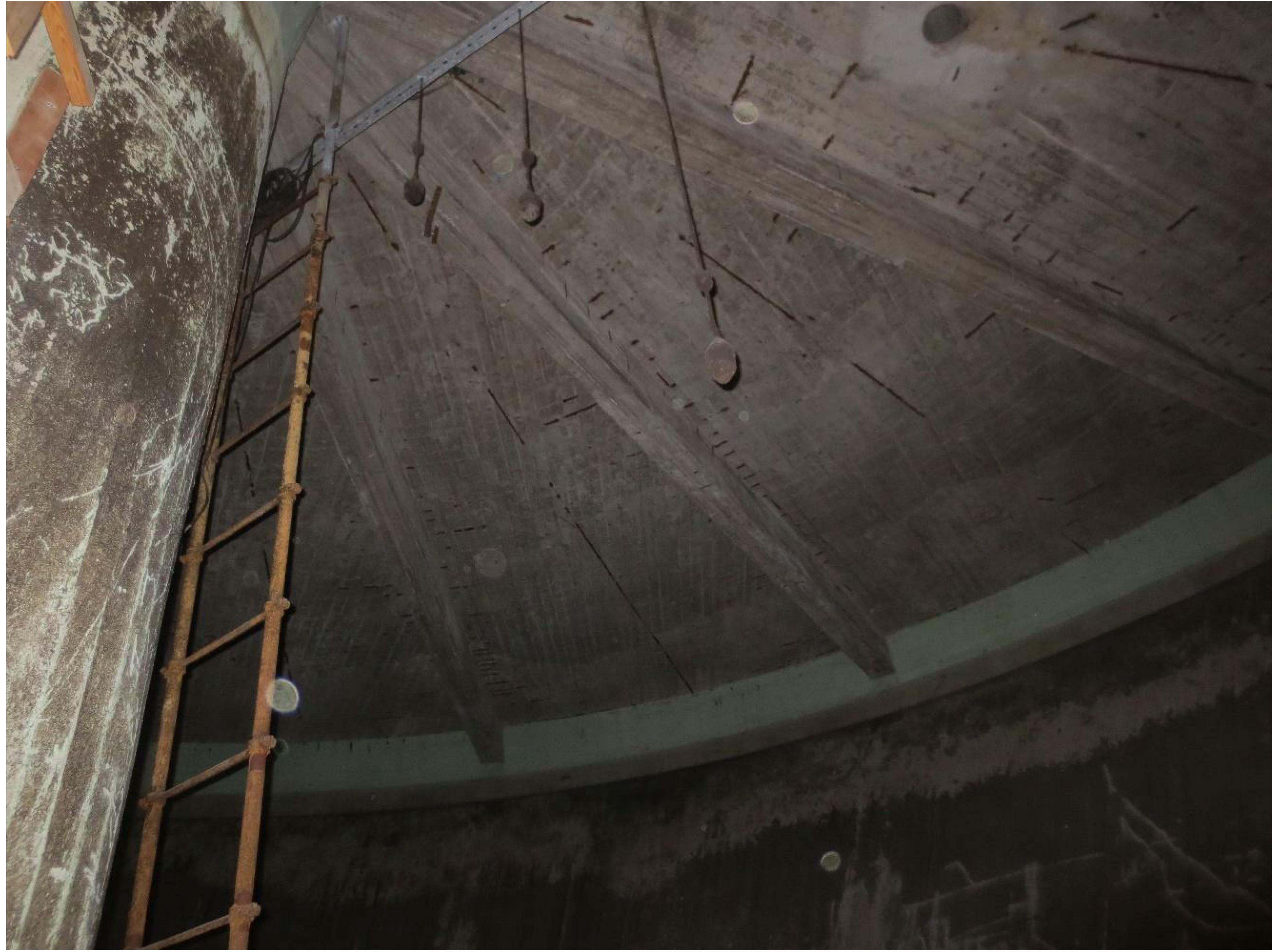
Kuva 5. Vesitornin säiliön kattorakenne
