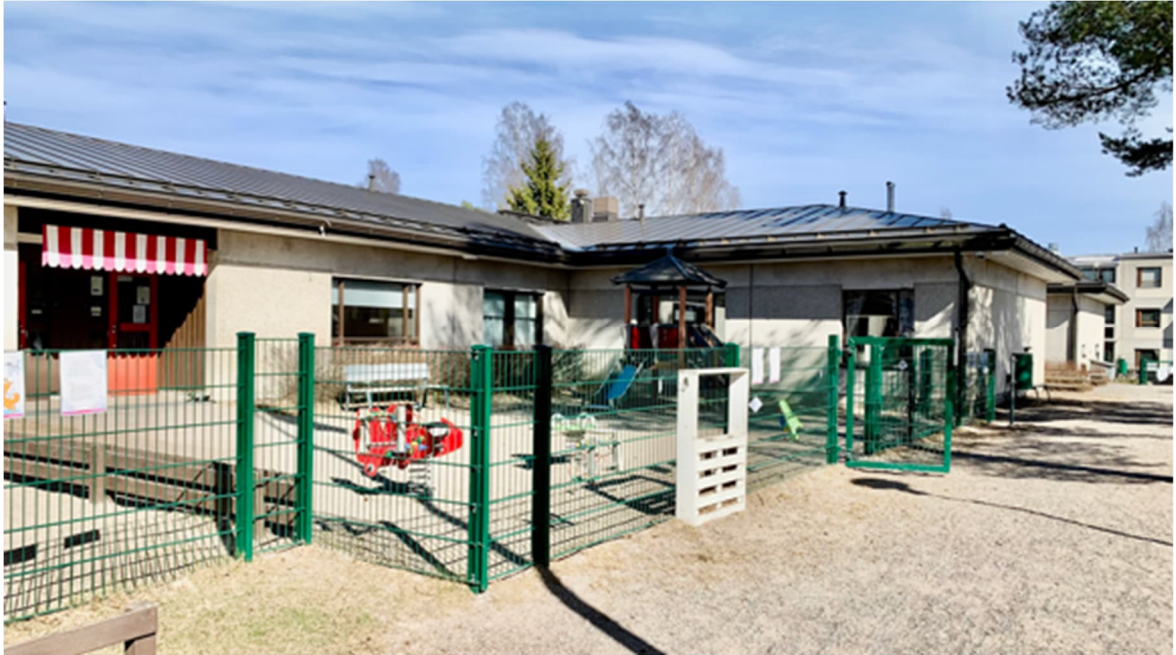
Vantaanlaakson päiväkoti. Julkisivut ovat betonia.
