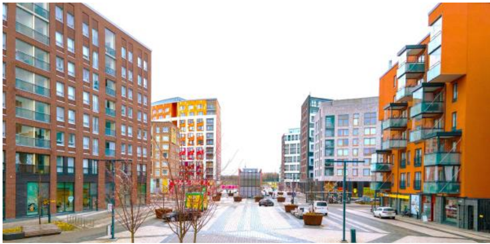
Kivistön Safiiriaukiota ympäröivien rakennusten maantasokerrokset on varattu liiketilalle.
