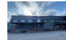
14. KOy Vantaan Helikopteritukikohta 2009
