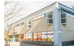
6. Pallastunturintien Liikekiinteistö Oy 1977
