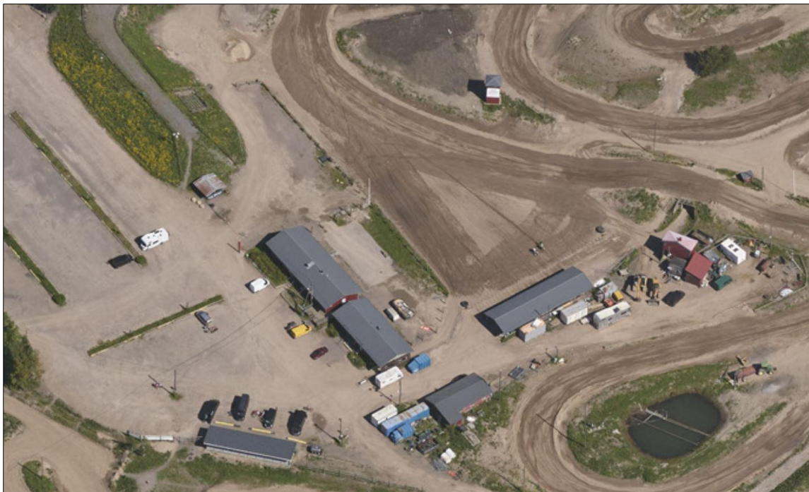
Kuva 2. Viistoilmakuva Kiilan motocrossalueen nykyisistä rakennuksista.
