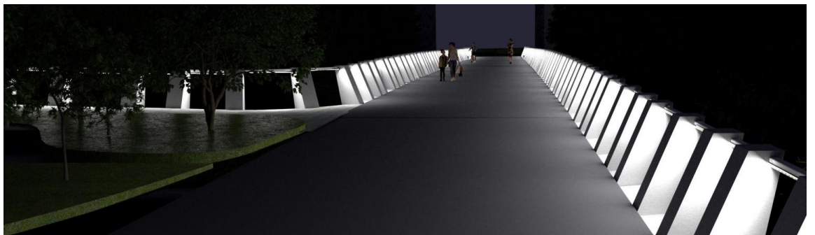
Kuva 34. Siltakannen valaistus (kylmä). (A-Insinöörit Oy)
