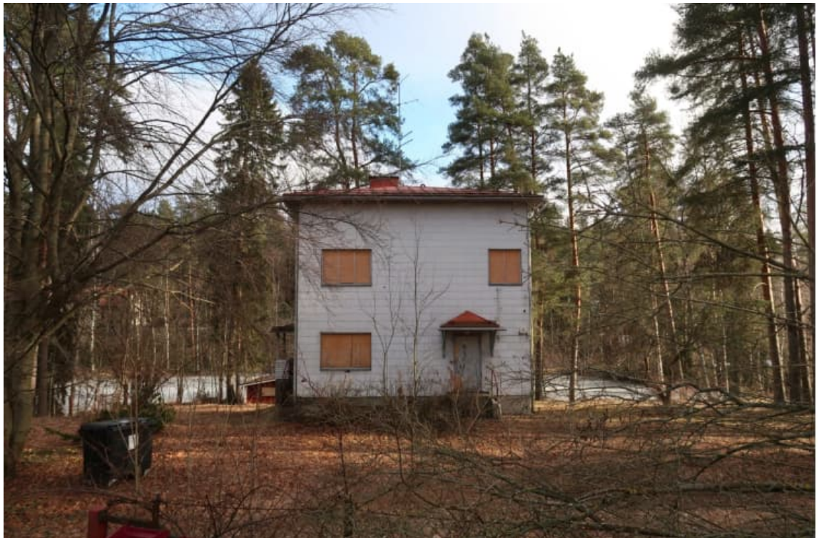
Näkymä Hiiripolulta. Valokuva Afry Oy / korjattavuusselvitys.
