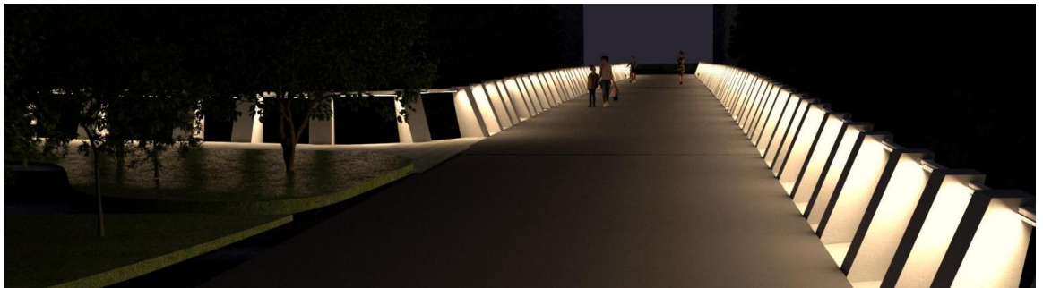
Kuva 33. Siltakannen valaistus (lämmin). (A-Insinöörit Oy)
