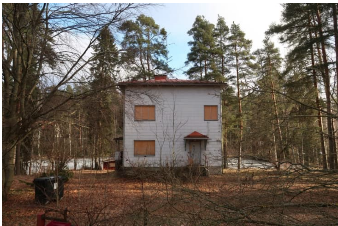
Näkymä Hiiripolulta. Valokuva Afry Oy / korjattavuusselvitys.
