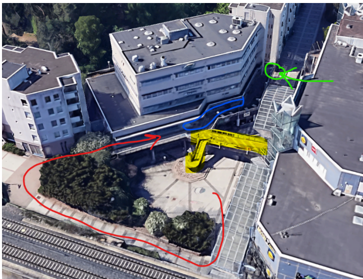
Kuva: Purettu kävelysilta ja portaat on merkitty keltaisella, liiketila sinisellä, kulku liiketilaan Paalukylänpolkua pitkin punaisella ja kulku porraskäytävään vihreällä. (Google maps)
