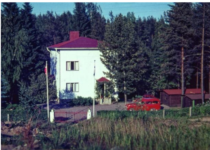
Rakennuksen julkisivupintaan on asennettu mineriittilevyt ja kattomuoto muutettu. Klaus Salkolan kokoelma.
