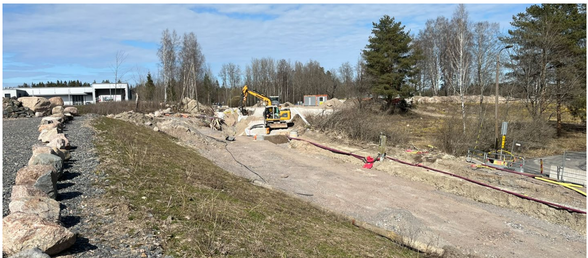
Näkymä suunnittelualueen itäosasta huhtikuussa 2026. Kuvassa oikealla Siirtolanpolun jalankulku- ja pyöräilyreitit keskeneräinen työmaa. Suunnittelualueella ei ole yhtäkään puuta tai pensasta.
