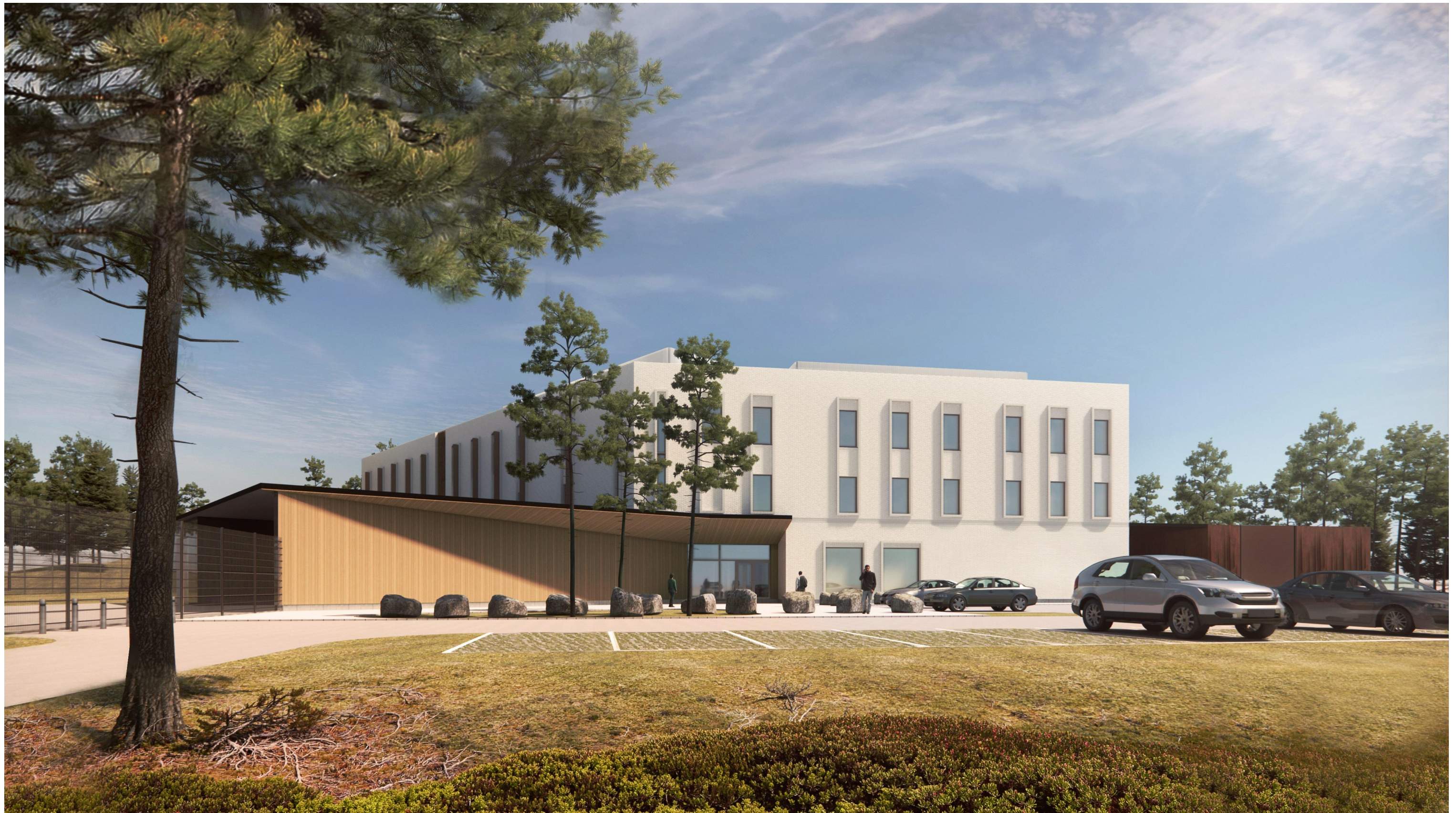
Näkymä Siltaniitynkujalle. Rakennuksen pääsisäänkäynti. Julkisivu itään.
