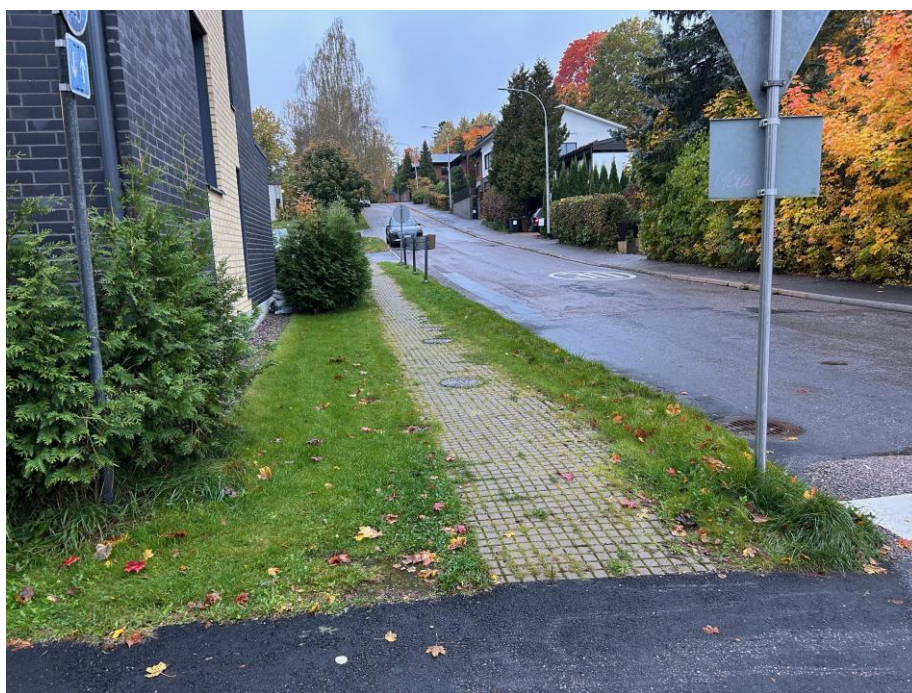
Kuvia havaituista puutteista
