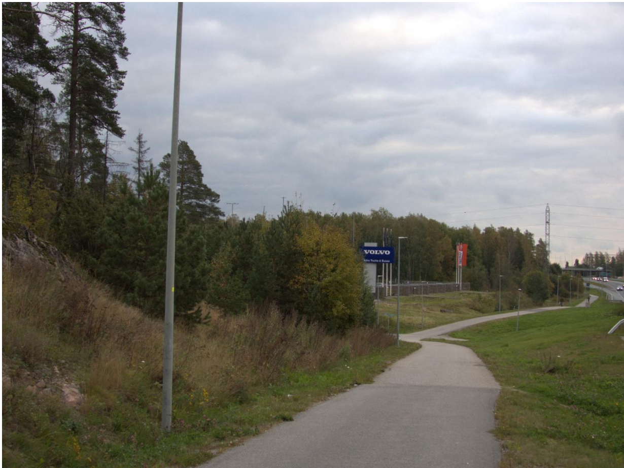
Kuva 18. Kuvauspaikka 4: Näkymä Kehä III:n pohjoispuolella olevalta kevyenliikenteenväylältä idän suuntaan. Voimajohto tulee sijoittumaan kuvasta katsottuna väylän vasemmalle puolelle. Kuvan etualan vasemmassa reunassa olevaa puustoa poistetaan voimajohdon tieltä. Voimajohtopylväät sijoittuvat kuvan keskikohdille kevyenliikenteenväylän vasemmalle puolelle ja Kuvan oikealla puolella näkyvien punaisten lippujen oikealle puolelle. Kuvassa taustalla näkyy Tammisto-Tolkinkylä 110 kV:n voimajohto.
