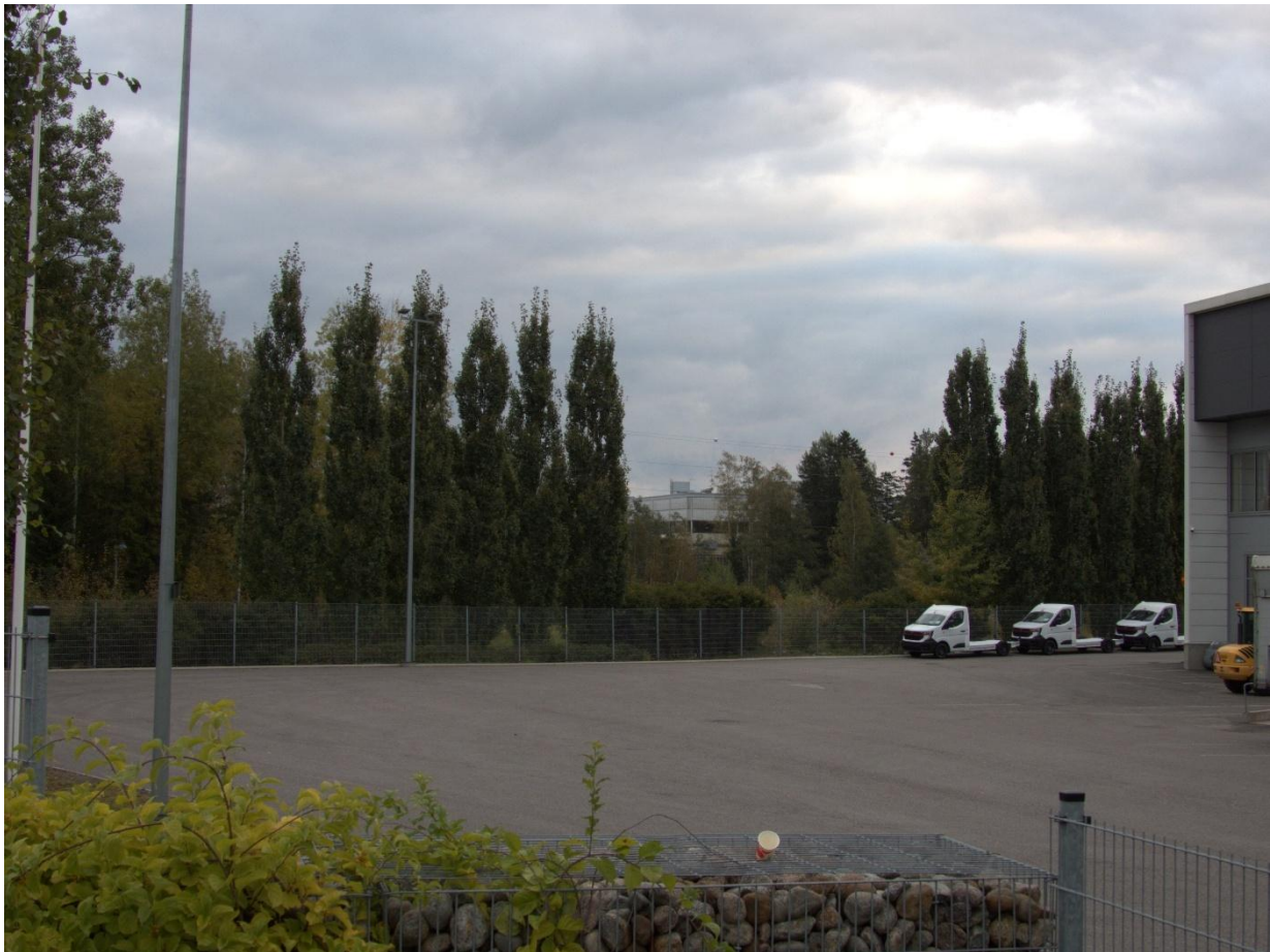
Kuva 15. Kuvauspaikka 1: Näkymä Tikkurilantien varrella kulkevalta kevyenliikenteenväylältä parkkipaikan poikki Osumapuistoon. Aviapoliksen sähköasema tulee sijoittumaan kuvan vasemmassa laidassa olevan metsikön taakse. Suunnitellun voimajohdon ensimmäinen pylväs sijoittuu kuvan oikeassa laidassa olevan metsikön kohdalle. Osumapuiston metsikköä kaadetaan voimajohdon reitin kohdalta Osumapuiston länsipuolelta kulkevan kevyenliikenteenväylän tuntumasta, mutta puustoa jää suunnitellun voimajohdon ja kuvassa taustalla näkyvän Tammisto-Tolkinkylä 110 kV:n voimajohdon väliin.
