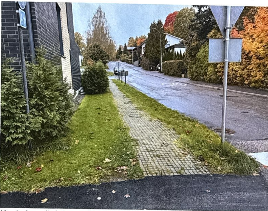
Kuvia havaituista puutteista
