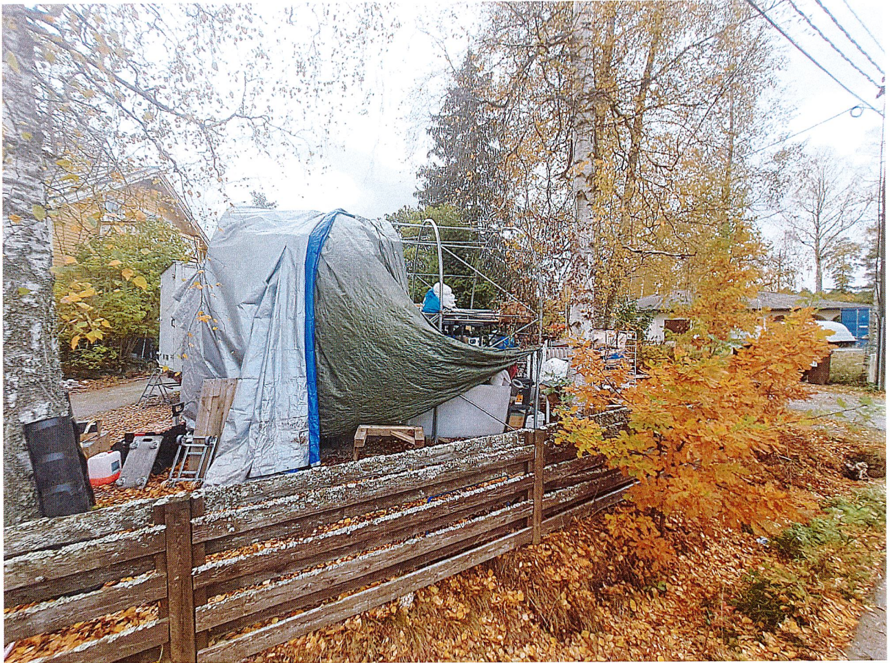
Kuva 2. Kiinteistön pohjoiskulmassa sijaitseva huonokuntoinen pressutalli kuvattuna toisesta suunnasta Paasitieltä.
