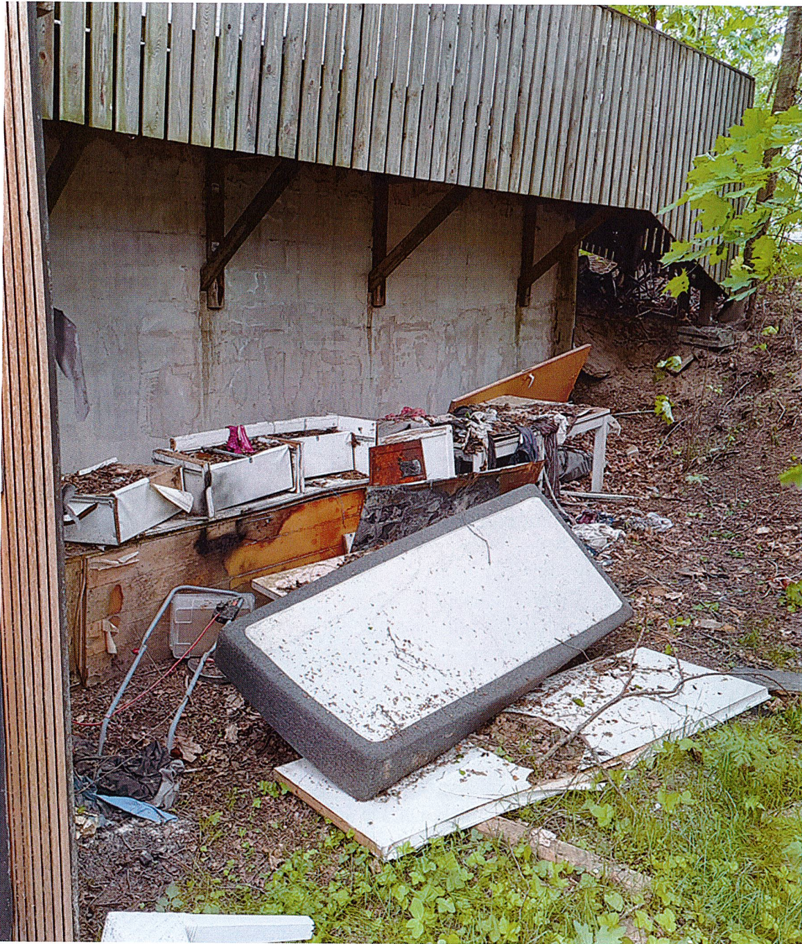
Kuva 5: Pihamaalla myös muuta jätettä ja irtainta tavaraa.
