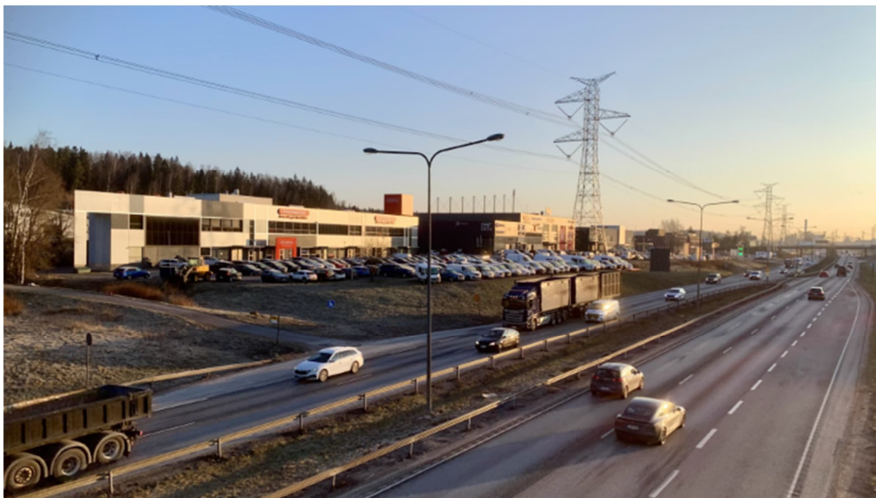
Näkymä Tiilipojanpolun sillalta Kehä III:lle ja kaava-alueelle.
