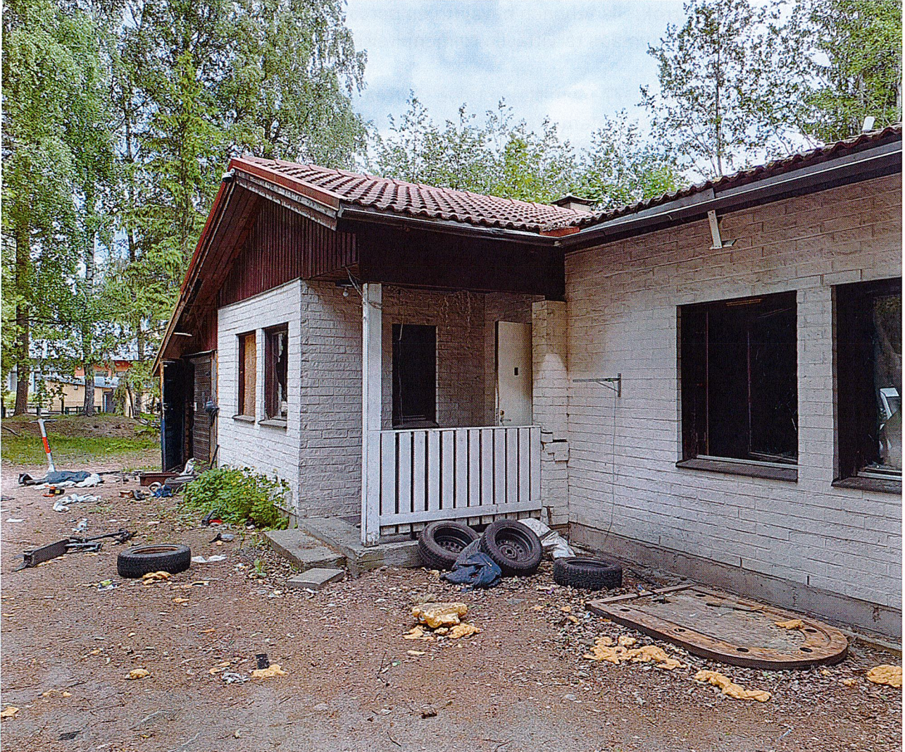
Kuva 1: Rakennuksen etupiha Ilolan koulun suuntaan. Ovet auki, ikkunat rikki, irtaimistoa levitelty pihamaalle.
