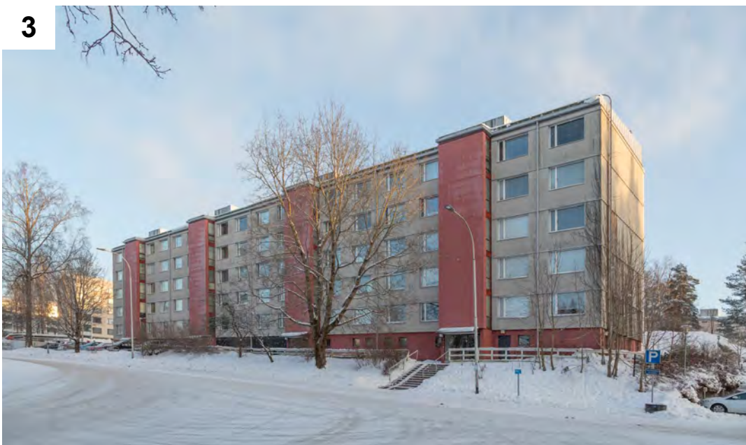
3 Kiskanpuiston takainen itäinen naapurirakennus
