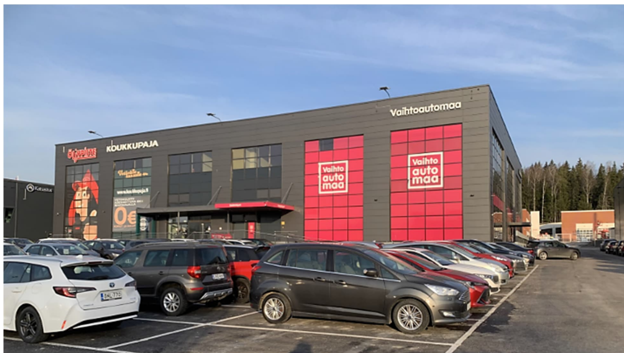
Tiilipojanlenkki 4a Kehä III:n ja pihan suuntaan.
