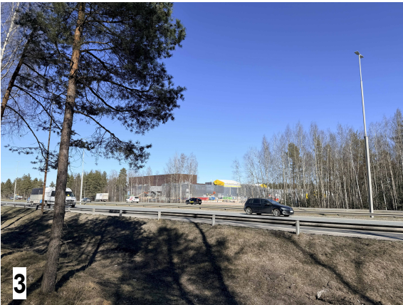
3 Honkanummi sähköaseman suunnalta kuvattuna
