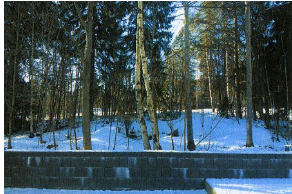
4. Vapaalankuja 4:n tontilta puistoon. Muuri.
