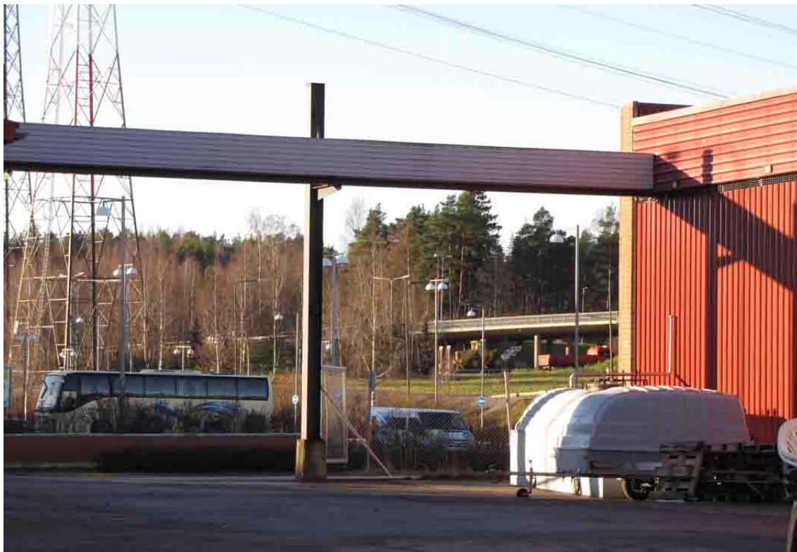
Näkymä tontin lounaisnurkan Vanhan Porvoontien ja KEHÄ III:n risteykseen, oikealla huoltorakennus.
