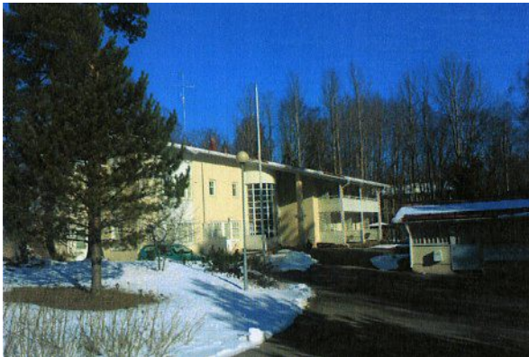
11. Vapaalantie 7 Vapaalantien suunnasta.
