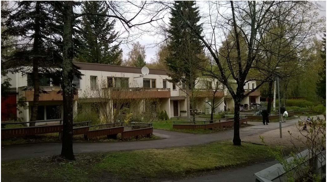
Kuva 5. purettavat 2-kerroksiset asuinrakennukset
