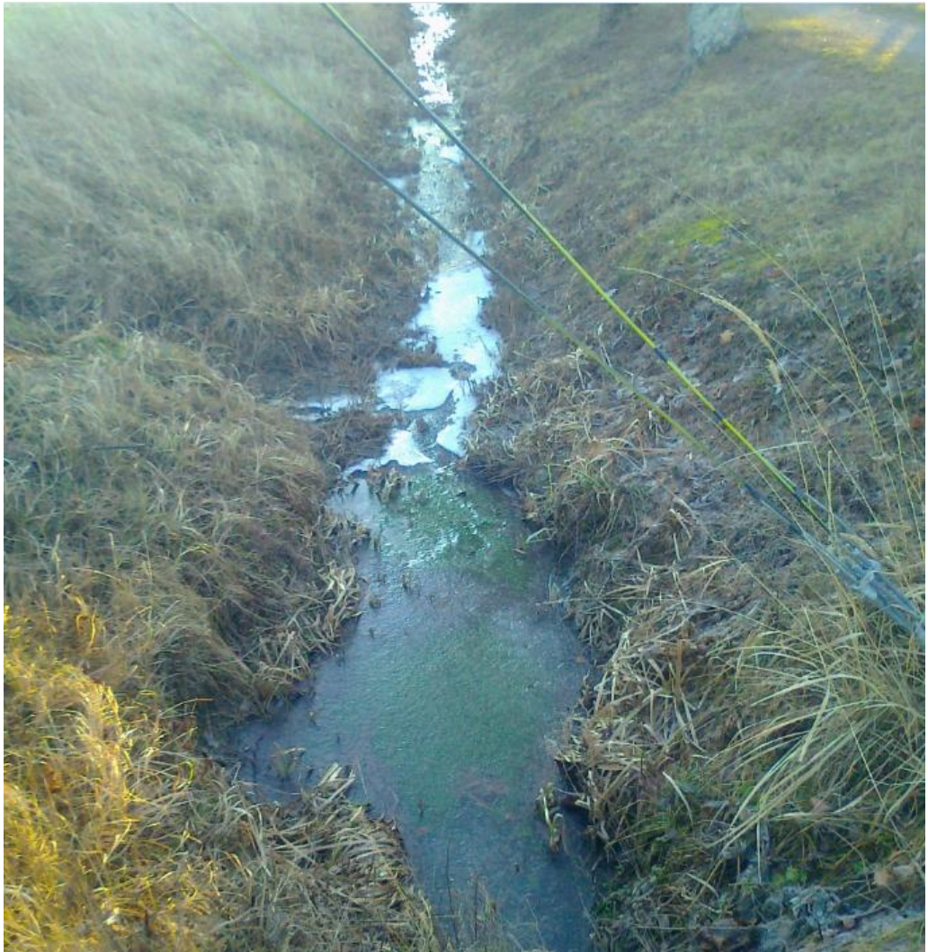
Kuva 11. Avo-ojan uoma, suunnittelualueen kohdalla, luoteen puolella.
