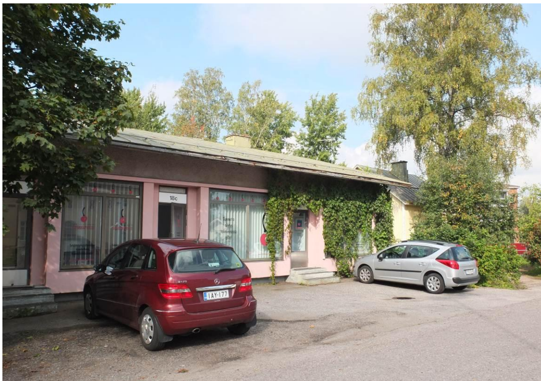
Kaavamuutosalueella sijaitsee 50-luvulla rakennettu myymälärakennus, kuva otettu syksyllä 2014.
