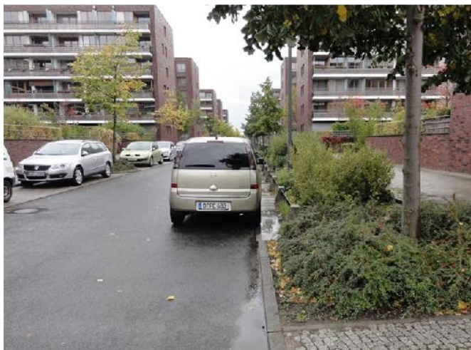
Kuva 124. Luonnonmukaista hulevesien hallintaa kadulla Berliinin Stralaussa. Kadun hulevedet valuvat painanteeseen, jossa on rehevää kasvillisuutta. Laajaniitynkujan hulevesien hallintaa voitaisiin toteuttaa tämän tapaisesti.
