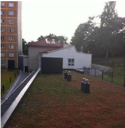
Kuvat 94-95. Viherkatto vähentää muodostuvan huleveden määrää ja hulevesiallas viivyttaa hulevesiä.
