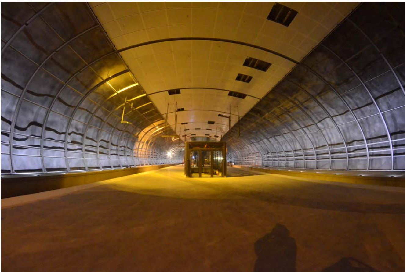
Kuva. Kehäradan asemat valmistuvat yksi toisensa jälkeen.
