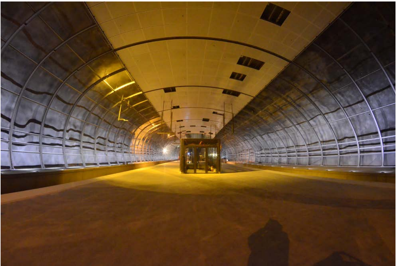
Kuva. Kehäradan asemat valmistuvat yksi toisensa jälkeen.
