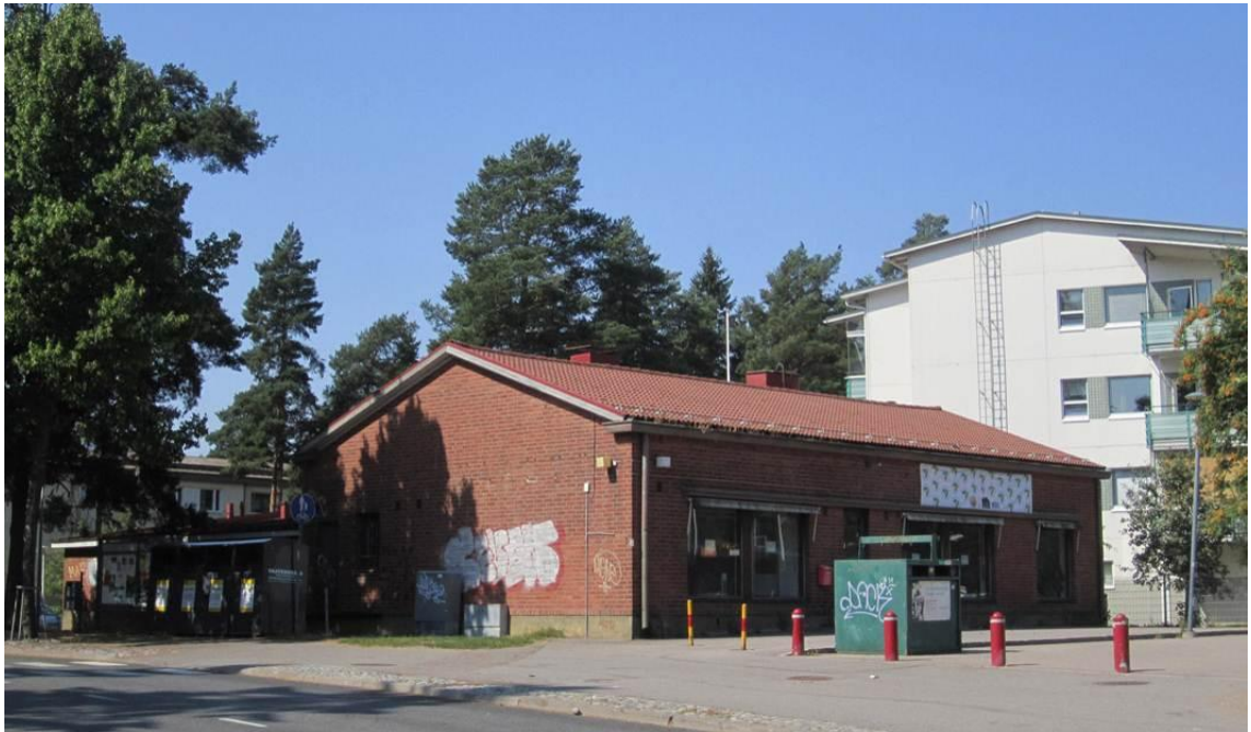
Muutostontilla sijaitseva myymälärakennus kesällä 2014.
