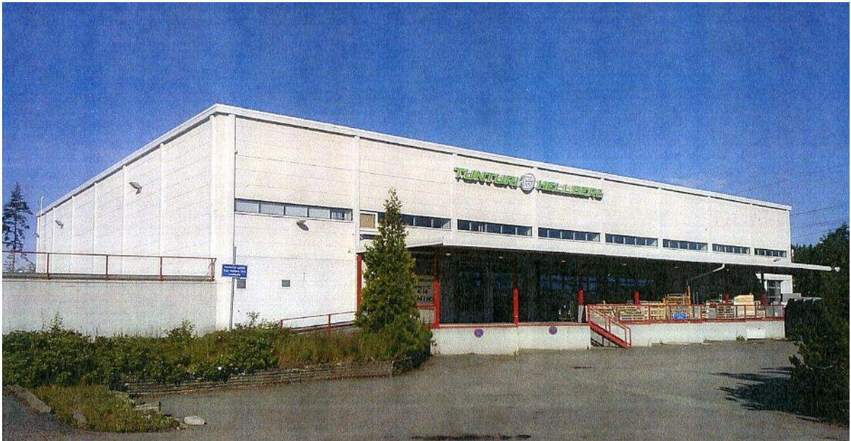
Riihimiehentie 8, julkisivu Riihimiehentielle.
