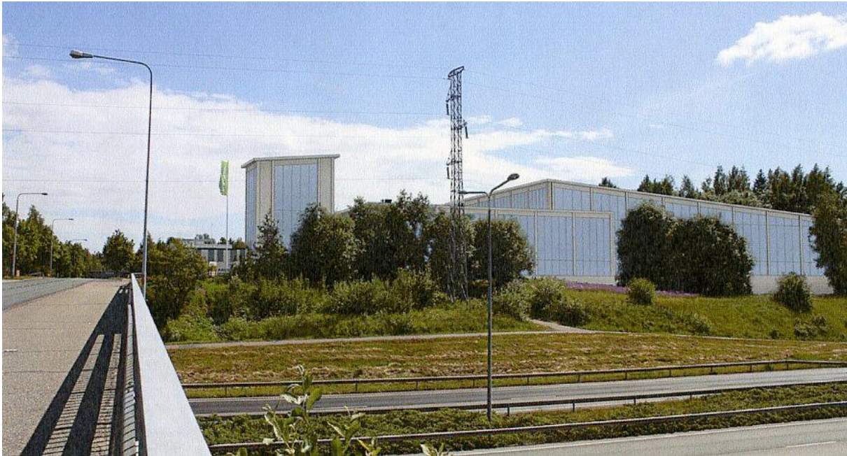
Näkymä Kehä III:n ylittävältä Riihimiehentien sillalta.
