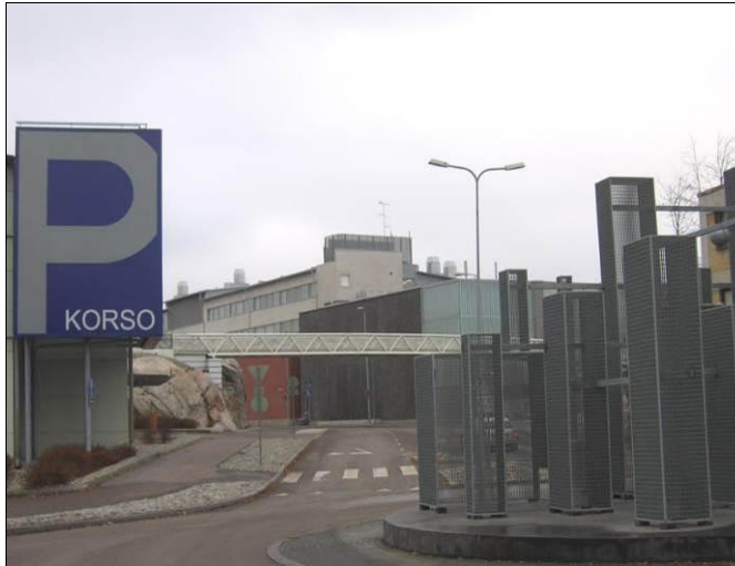
Näkymä pohjoisesta, vasemmalla p-talo, keskellä Lumo-talo, oikealla purettava talo.
