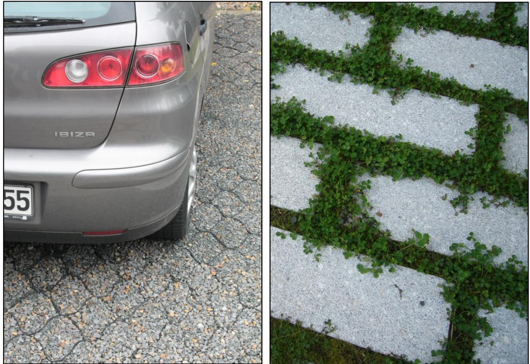
Kuva 5. Läpäiseviä pintoja, v. soralla täytetty kennosto p-alueella, o. kiveys leveillä nurmisaumoilla.
