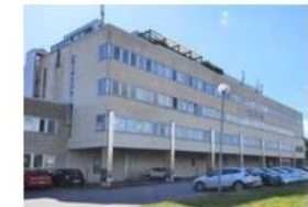
16. K Oy Korson Terveysasema 1992/1997
