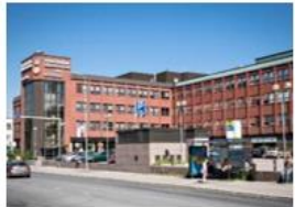
4. K Oy Tikkurilan Terveysasema 1979/1982
